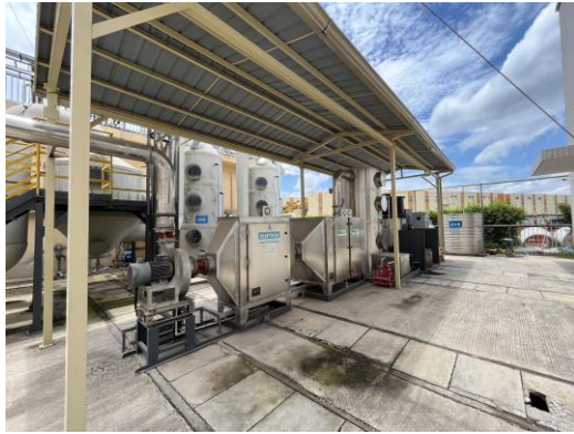
废负极极片燃烧废气处理设施
